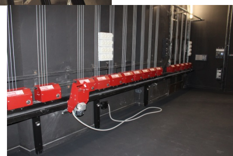
Le système de levage des perches
